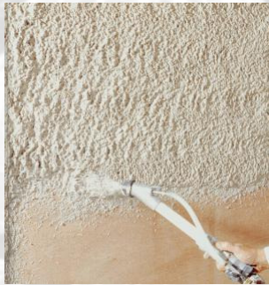
Quelle: Knauf „Auftrag von Maschinenputzgips“
